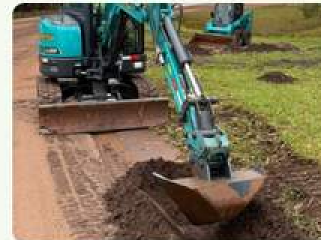
Drenagem e valas
